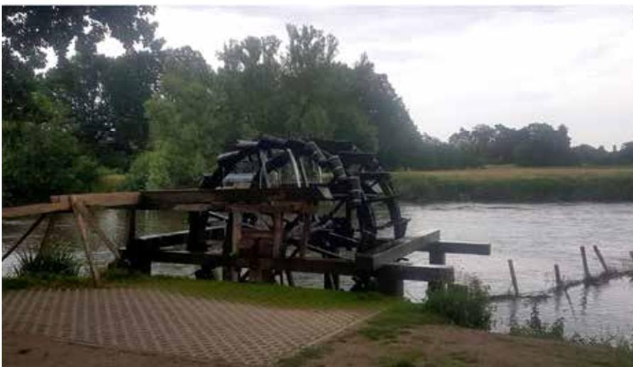
Vierzigmannrad. Die Wasserströmung ist hier so gering, dass das Wasserschöpfräder nur mit eingebauten Flügelbrettern betrieben werden kann. Das geschöpfte Wasser speist ein Feuchtbiotop.
